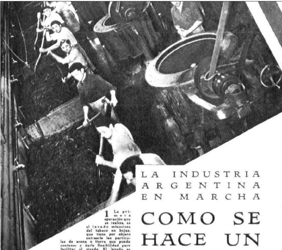
**1** La primera operación que se realiza, es el lavado minucioso del tabaco en hojas, que tiene por objeto extraerle las partículas de arena o tierra que pueda contener y darle flexibilidad para facilitar el picado. El lavado se hace en piletas especiales.
