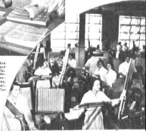
**15** Finalmente, la colocación de la estampilla del impuesto se hace en la sección estampillado, donde cada una de las máquinas de procedencia inglesa que se encarga de esta tarea, puede despachar 200 atados por minuto. En esta misma sección se realiza de inmediato, el empaquetado en cajas, quedando así listo el producto para salir a la venta.
